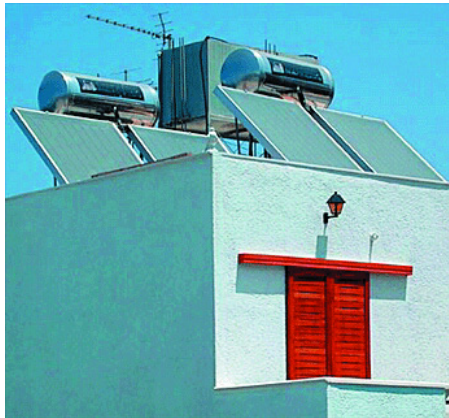
Abb. 10: Thermosiphon-Anlagen sind vor allem im mediterranen Raum anzutreffen, da hier die außenliegenden Speicher wenig Verluste haben und sich die Anlagen meist auch problemlos in die einfache Warmwasser- und Heizungstechnik integrieren lassen. Quelle: Lernsoftware Multi-SOL 2.0, www.multi-sol.de
